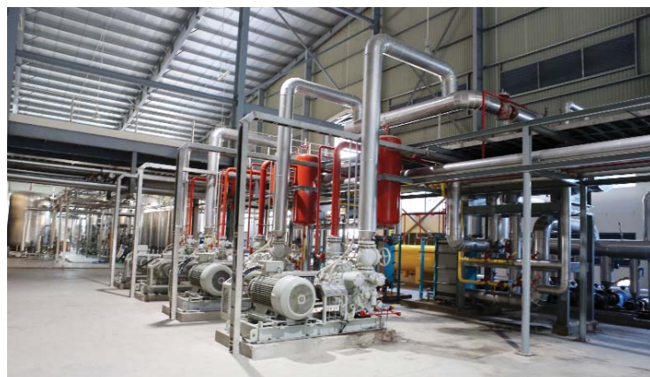
Hệ thống lạnh Nhà máy Bia Sài Gòn - Vĩnh Long (Hệ thống lạnh phân tầng - tiết kiệm năng lượng)
