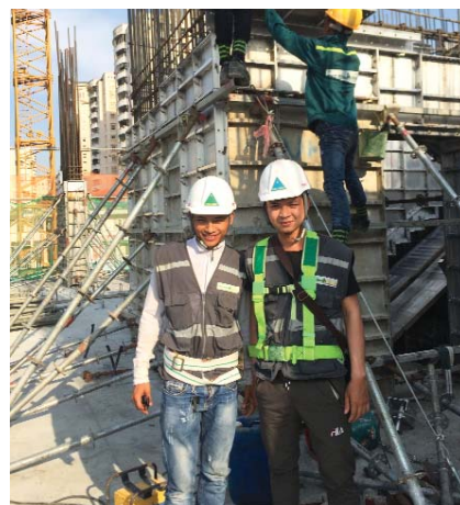
Sinh viên ngành Kỹ thuật Xây dựng tham gia thực tập tại công trường
